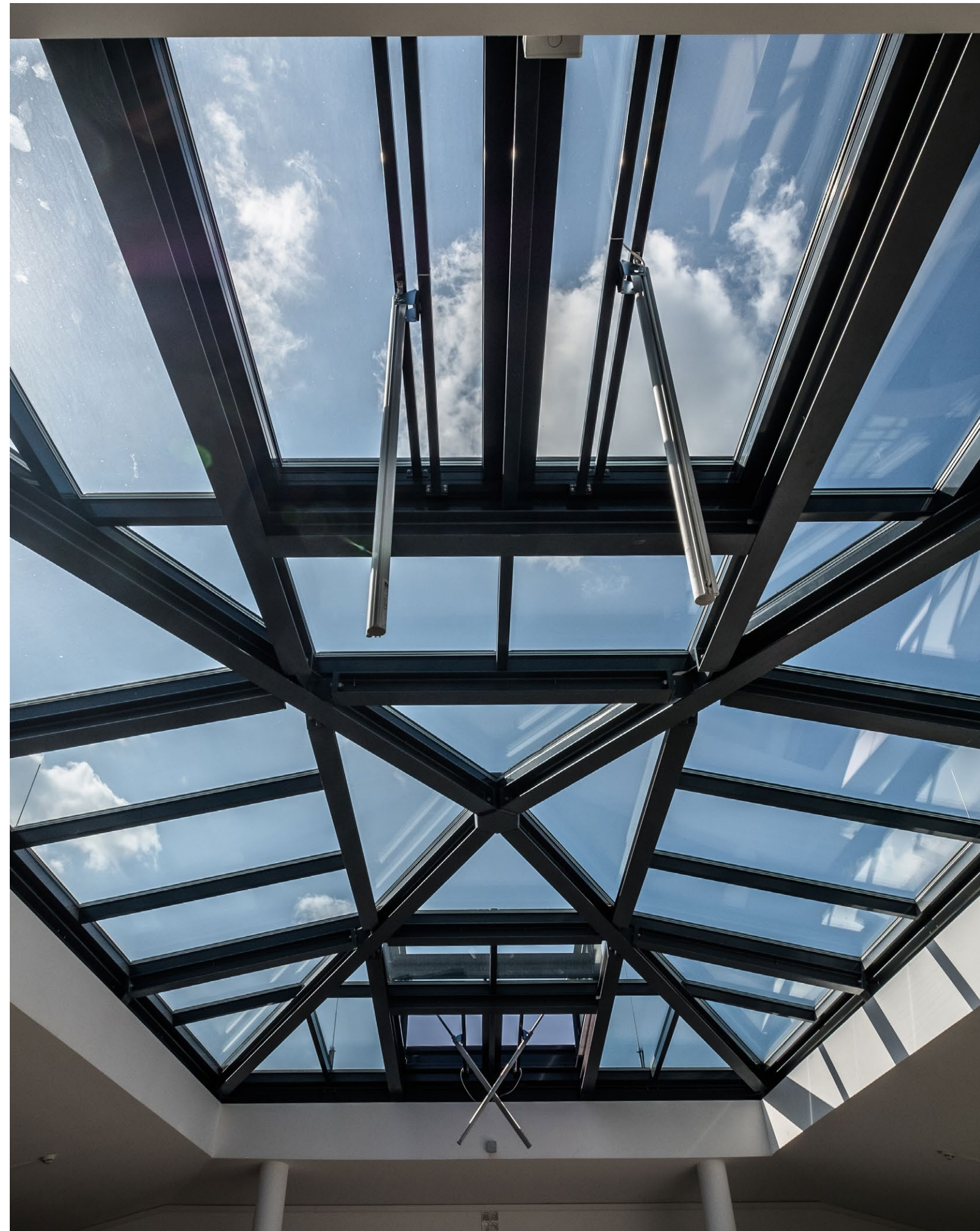
Montage sur costière en tôle d'acier
